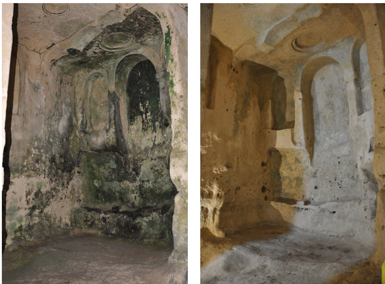
Fig. 5 Particolare delle superfici in calcarenite prima e dopo il trattamento biocida
