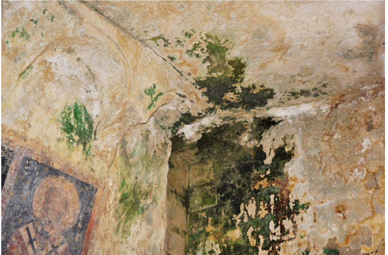
Figura 9: Infiltrazione d'acqua meteorica situato tra controfacciata e parete laterale destra.
