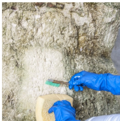
Figura 16: Risciacquo a seguito della prima spazzolatura.
