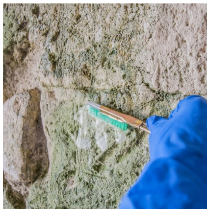
Figura 14: Applicazione a pennello del biocida.
