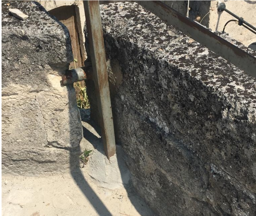
Figura 22: porzione di muratura da rimuovere per migliorare il deflusso dell'acqua.
