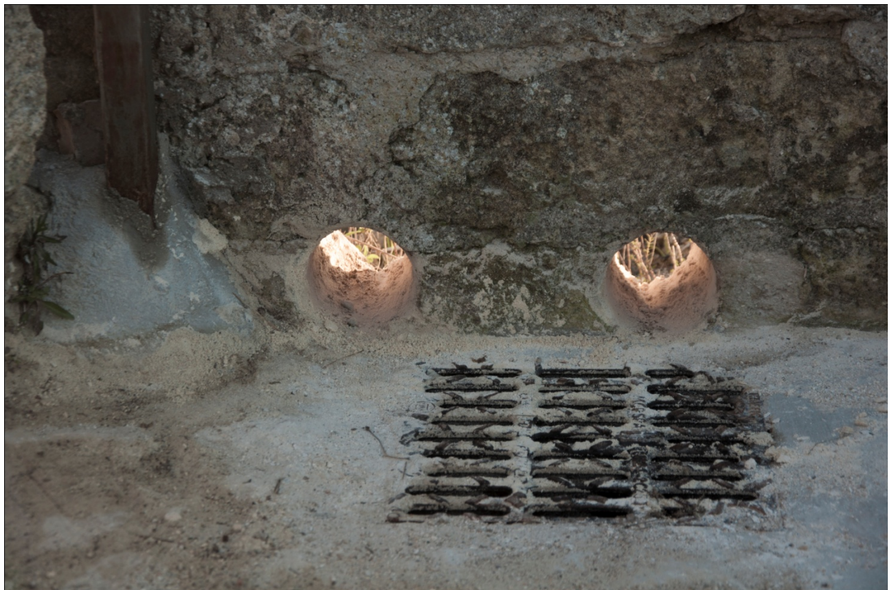
Figura 25: carotaggi eseguiti.
