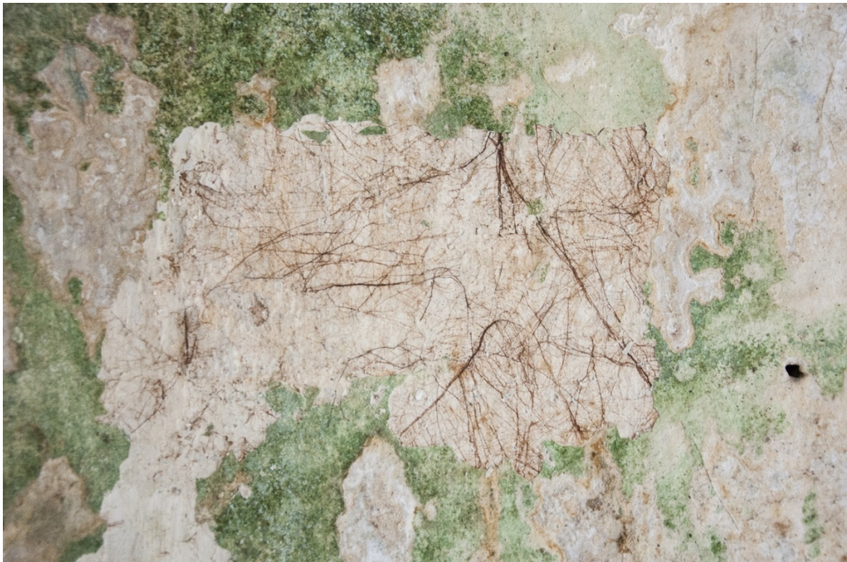
Figura 20: Particolare che mostra la presenza di ife al disotto della scialbatura degradata dall'attacco biologico.
