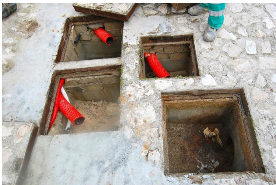
Tipologie di impianti che corrono lungo il lato nord del sito
